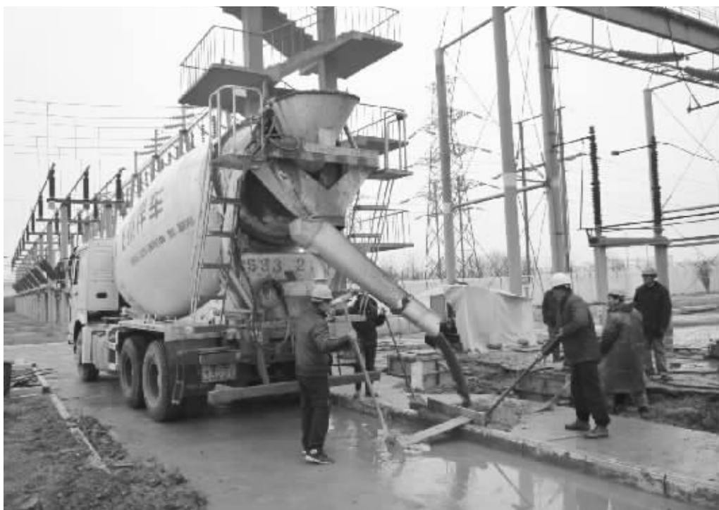
近日,信阳华祥电建集团建筑分公司在明港110千伏变电站扩建项目施工过程中,严格按工程周期施工。图为施工人员为保证工期正冒雨进行施工。 贾朝甫 摄
