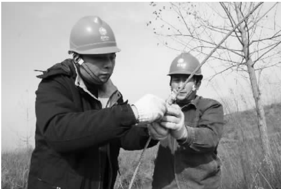
宁西铁路是我国“八纵八横”线路骨架的重要干线铁路之一,目前该线路已启动增建二线工程。铁路建设离不开电力,罗山县电业局获知情况后,及时与负责罗山县境内铁路增建工程负责部门联系沟通,征求意见,并最终确定在罗山境内铁路沿线的楠杆、子路、龙山、竹竿4个乡镇内,为其立杆架线、安装配变,提供优质的电能。图为12月2日,罗山县电业局施工人员在现场施工场景。 齐涛 魏思平 摄
