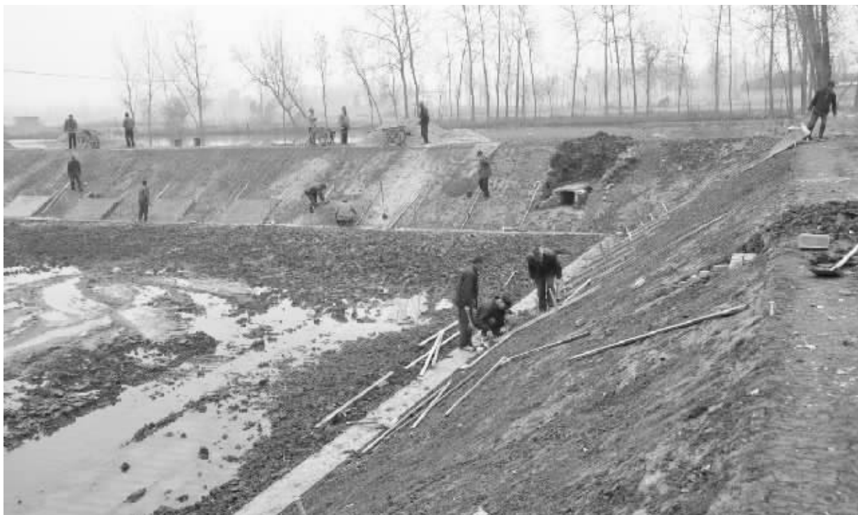
日前,平桥区甘岸办事处抓住农闲的有利时机,掀起了冬季农田水利建设的高潮。截至目前,已打机井36眼,整修灌渠2000多米,新修田间水泥路12千米。图为该办事处二郎村农民整修万方大塘时的情景。 王进履 甘语 摄
