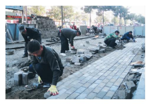
因使用时间较长,又 加之车辆的碾轧, 申城大 道西侧的人行道严重老 化,人行道上的地砖凹凸 不平, 不少地方的地砖已 经松动,并出现不少坑洞, 给市民出行造成极大不 便。为了给市民提供通畅、 平整、安全人行道,昨日, 市政部门组织工作人员对 这一路段的人行道砖进行 重新铺设。图为工人正在 铺设人行道砝
