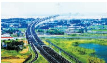
备受瞩目的泰州长江大桥本周末即将通车。“江苏地处长江下游,江面宽,通航要求高,长江上最复杂、规模最大的桥梁都在江苏,可以说江苏的桥梁代表着中国桥梁的建设水平。”江苏省交通规划设计院桥梁总工程师韩大章不无自豪地说。作为江苏第 8 座长江公路大桥,泰州大桥更是一举创下 5 项世界第一。首先就是 2x1080 米特大跨径三塔两跨悬索桥这一全新的桥梁结构体系属国际第一。江阴大桥和下周即将通车的南京长江四桥都是双塔单跨悬索桥。而泰州大桥在普通的双塔悬索桥中间,又加了一座主塔,三座桥塔将 3100 米的主缆拉成一个巨大的“W”形。(据《扬子晚报》)
