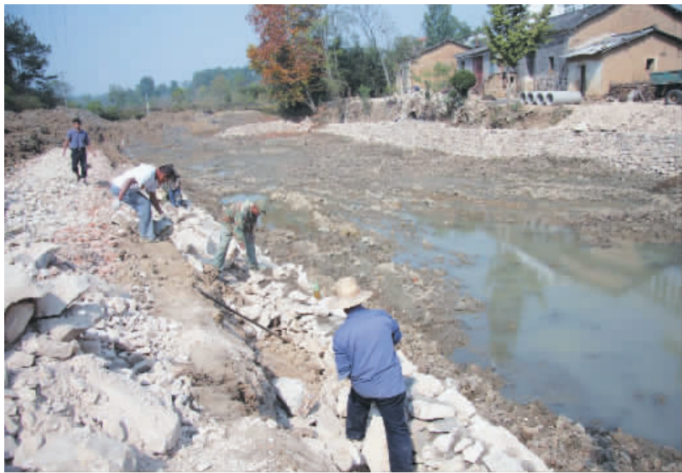
为抓好今年秋冬农业开发,罗山县青山镇掀起农田水利建设热潮。目前,该镇共投入资金180万元,新建扩挖塘堰10口、新增蓄水5万立方米。图为该镇陈洼村正在整修塘堰。方建兵 摄
