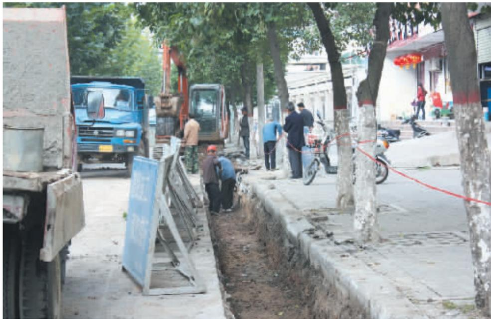
南湖路原物价局家属院门前至市特殊教育学校门前路段因下水道被堵,长期以来污水流到路面上,给附近居民的生活带来了不便,也严重影响了市容。后经附近居民多次反映,并经过本报报道后,得到了市政部门的重视。近日,市政部门正式对该路段的下水道进行施工改造,彻底解决该路段污水涌出下水道流到路面上的问题。图为工人们正在将路面挖开,准备安装管道。
