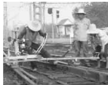
一段时间以来,为确保设备处于最佳状态,信阳工务段精心养护设备,开展了列车径路检查整治活动,为旅客列车安全运行提供保障,为党的十八胜利召开保驾护航。图为该段利用“天窗”点时间打磨道岔。刘淑娟 摄
