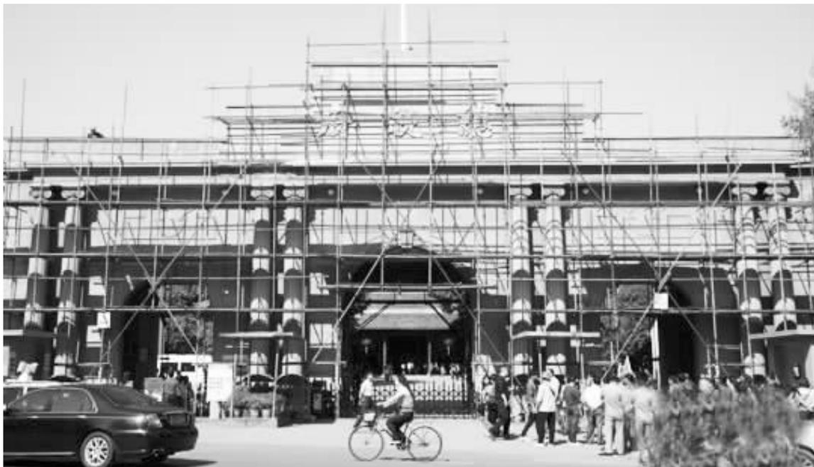
10 月 17 日,游客在搭建了脚手架的南京总统府大门楼前参观。始建于 1929 年的南京“总统府”大门楼是个标志性建筑,前段时间有专家检查时发现,由于 20 世纪的排水系统失效,雨水会顺着裂缝进入墙体内部,威胁门楼,为此南京总统府大门楼开始维修,迎来首次“大手术”。
