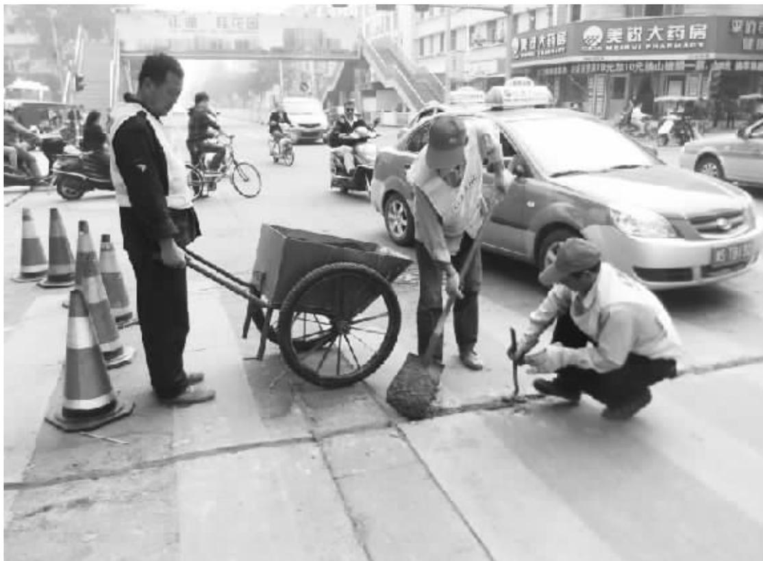
近期,我市交警部门对市内各个路口的已坏红绿灯进行维修更换。图为路政工人正在对胜利北路步行街和东方红大道交叉路口的红绿灯设施进行地面通电电线管道铺设。见习记者 周亚涛 摄
