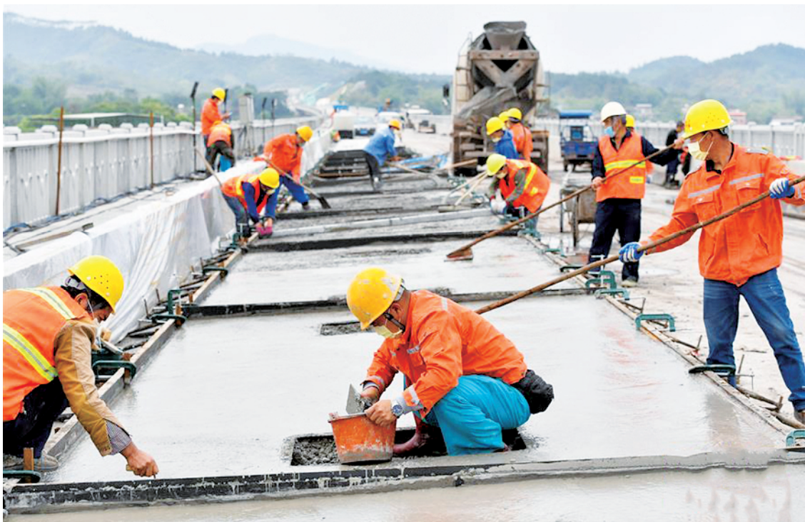
4月7日,中铁四局施工人员在赣深铁路五标段福田埔特大桥进行无砟轨道混凝土浇筑施工。当日,中铁四局承建的江西赣州至深圳高速铁路五标段开始无砟轨道混凝土浇筑施工。赣深铁路是京九高铁的最南段,设计时速350公里,建成通车后乘高铁从深圳至赣州仅需两小时。
