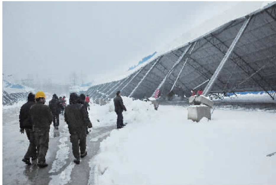
近日,河南恒顺植物纤维板有限公司厂房南部由于屋顶积雪很厚,造成该公司的钢构房屋的承载重力严重超过其强度,致使部分房屋坍塌或受损,该公司两个堆料大棚完全坍塌。图为公司员工在受损的堆料大棚前进行生产自救的情景。
