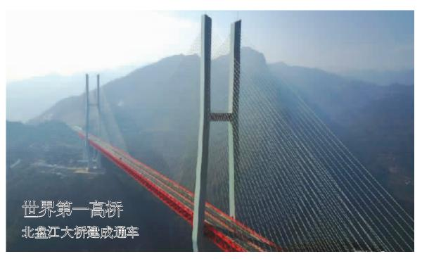
12月29日,由贵州、云南两省合作共建的世界第一高桥-—杭瑞高速贵州省毕节至都格(黔 滇界)高速公路北盘江大桥建成通车。北盘江大桥是杭瑞高速毕都段的控制性工程,位于云南省和 贵州省交界处,北盘江大桥桥面至江面高差达565米,超越之前世界第一高桥四渡河特大桥的560 米,成为目前世界第一高桥,大桥主桥为钢桁梁斜拉桥,主跨720米。 中新社记者 贺俊怡 摄
